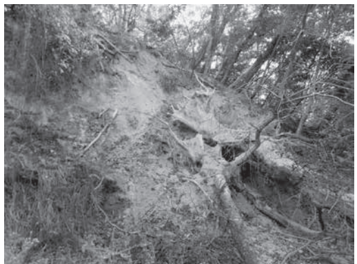
ワコールグラウンドの周辺の崩落箇所
